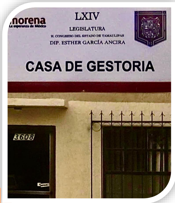
Las puertas de la casa de gestión ubicada en Héroe de Nacataz No. 3608 sector centro, en Nuevo Laredo, se encuentran siempre abiertas para brindar diversos servicios de apoyo a la sociedad
